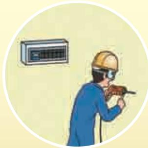
■ 工作前要確認使用電動工具接妥漏電斷路裝置。
