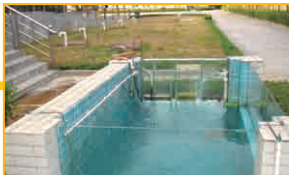
■ 石華堂建有自己的廢水循環系統，經處理後的廢水乾淨清澈，可供養魚、沖廁及淋花之用。
