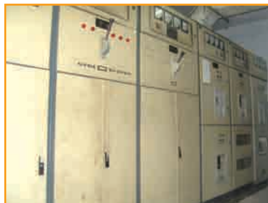
■ 電力並網工程實現市電與自發電的無縫切換，減少斷電停機所產生的種種問題。
