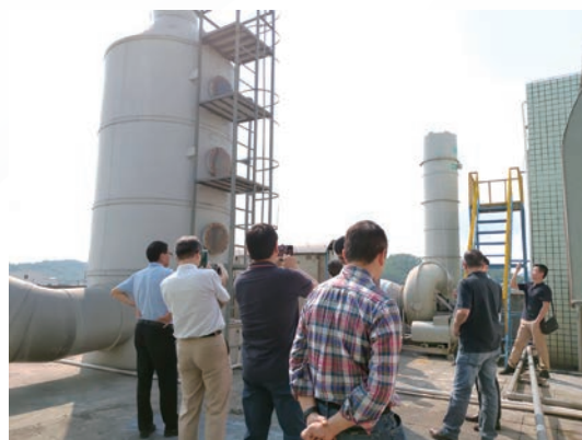
■ 參加者實地參觀振興的化學洗滌有機廢氣淨化系統。
