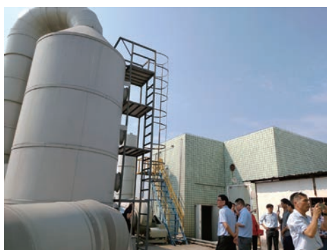
■ 參加者實地參觀振興的化學洗滌有機廢氣淨化系統。
