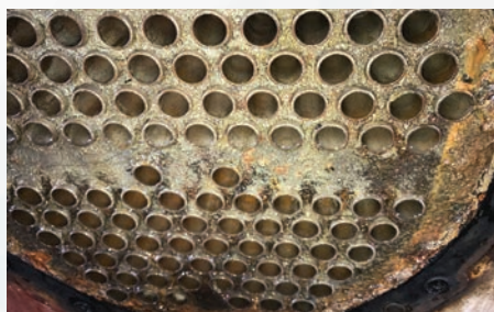
■ 清除水垢後的冷凝器
