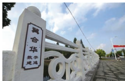
■ 首次利用3D打印技術改造危橋欄杆，更加節省成本、時間和人手。
